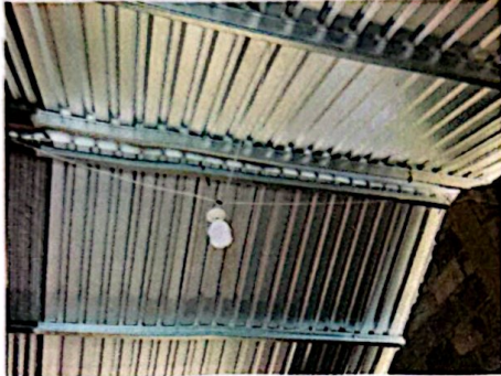
Foto 1: Mejoramiento de sistema eléctrico
