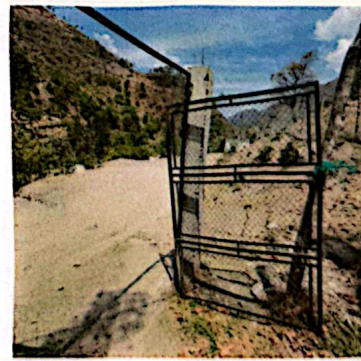
Foto 6: Mantenimiento a portón
