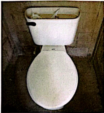
Foto 3: Mejoramiento de servicio sanitario
