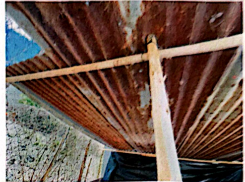
Foto 2: Instalación de estructura de techo
