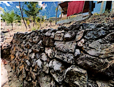
Foto 5: Mantenimiento de muro de contención
