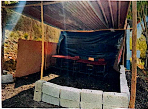
Foto 1: Mejoramiento aula tipo pórtico
