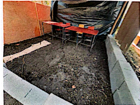
Foto 4: Mejoramiento de piso
