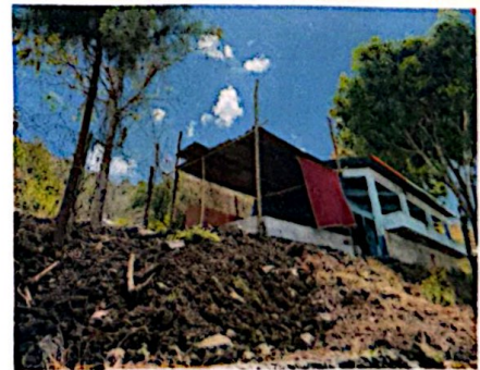
Foto 6: Mejoramiento de módulo
